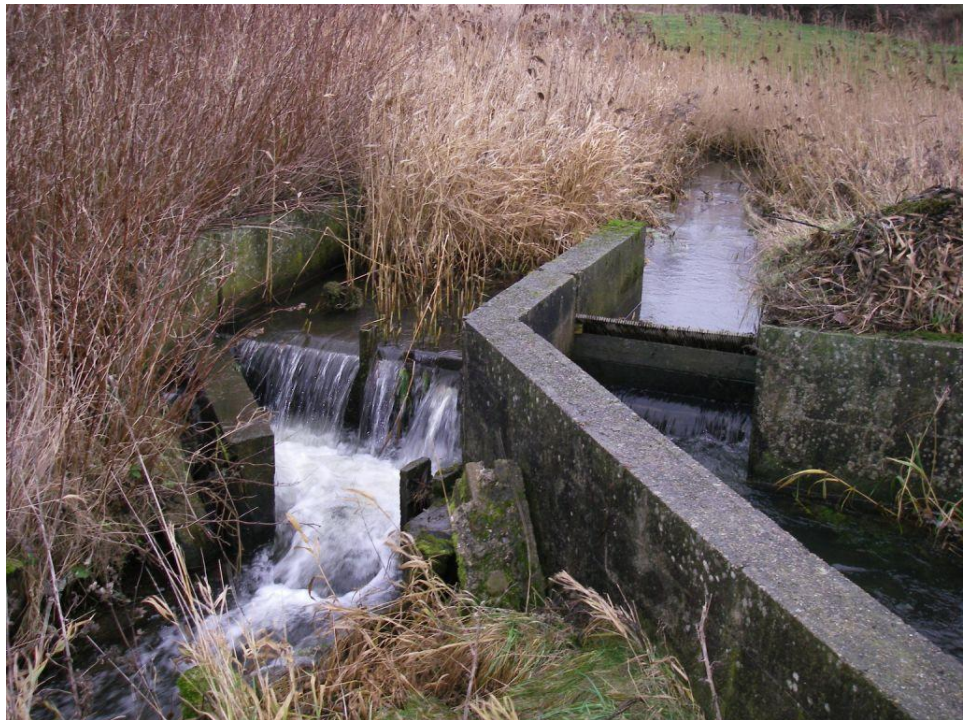
Foto 1. Opstemning i Beersted Bæk ved Todbøl Dambrug. Til højre ses vandindtaget til dambruget
